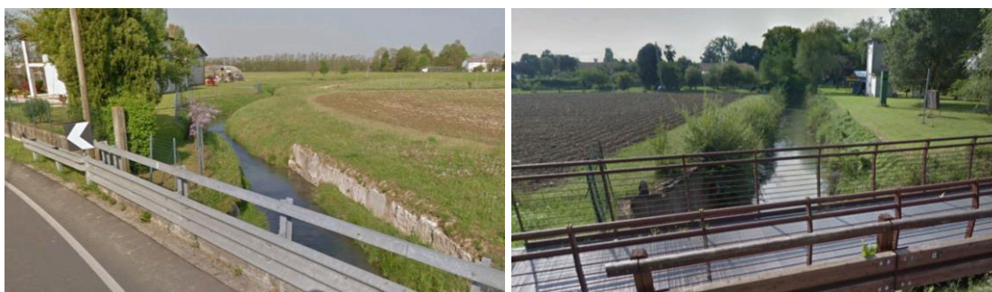
Figura 37. Tratte dello scolo Dosson.
